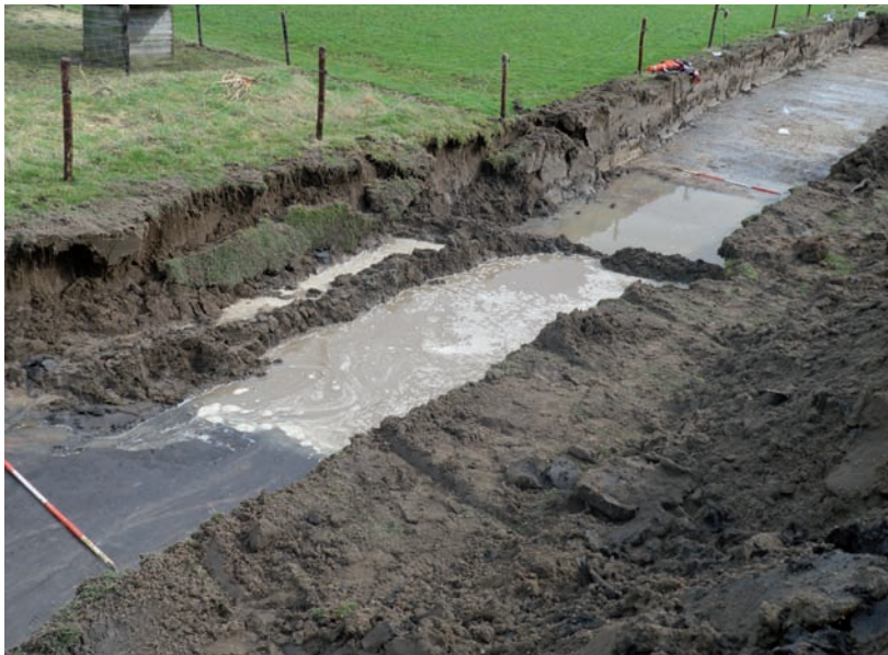
Afb. 2.2 Situatie sporenvlak met grondwater in werkput 2.
